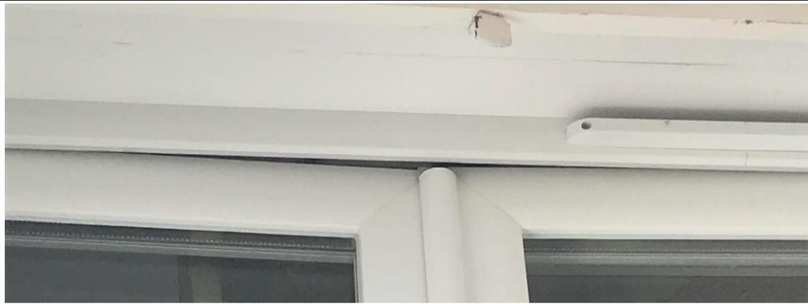
*Photo de la malfaçon dans la menuiserie, signalée par l'habitante (vue de l'extérieur).*
